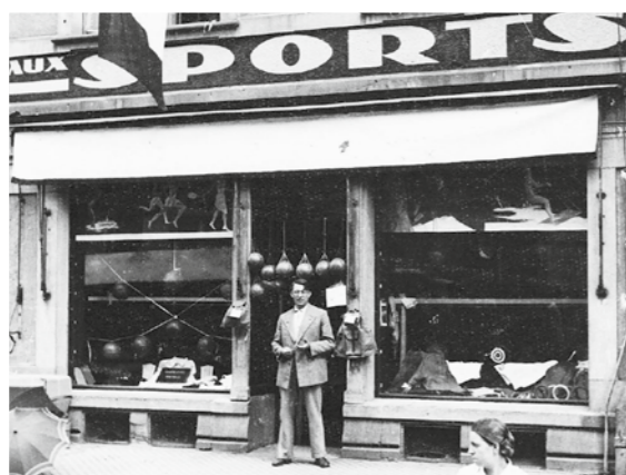
Où tout a commencé: le magasin de sports à Colmar en 1935 Where it all started: the sports store in Colmar in 1935
